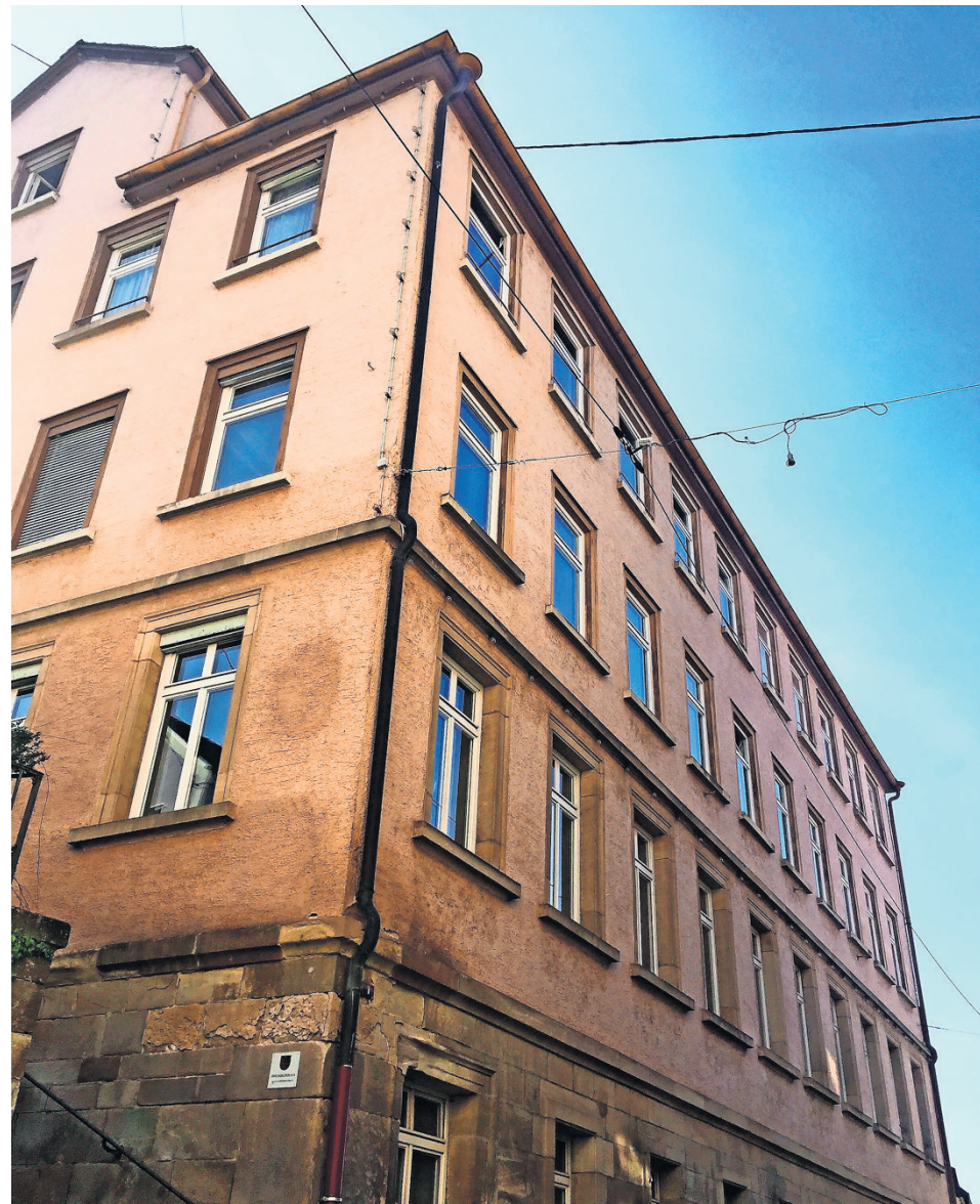
Das Hölderlinhaus soll nach wie vor entkernt und aufgestockt werden. Foto: Thomas Krazeisen
